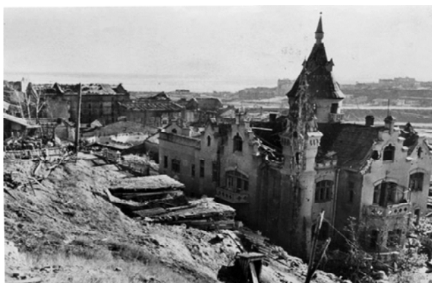
Фото 4. Дом Миллера после окончания Сталинградской битвы. На переднем плане, возможно, один из входов в массовое газобомбоубежище, разделенный на две части
